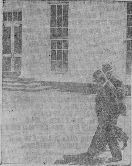
El presidente Hoover, examinando la sección de la Casa Blanca seriamente dañada por un incendio la Noche Buena, y cuyas reparaciones están al término.
